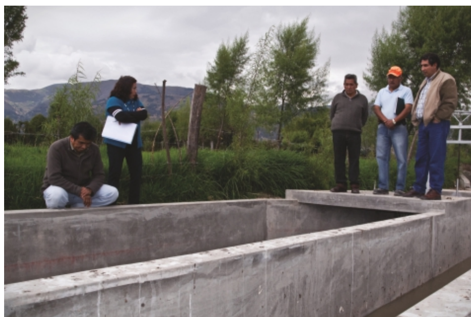
Supervisión del servicio de agua potable - San Nicolás de Chaullagón Sistema de Agua Potable. Educación Sanitaria.
